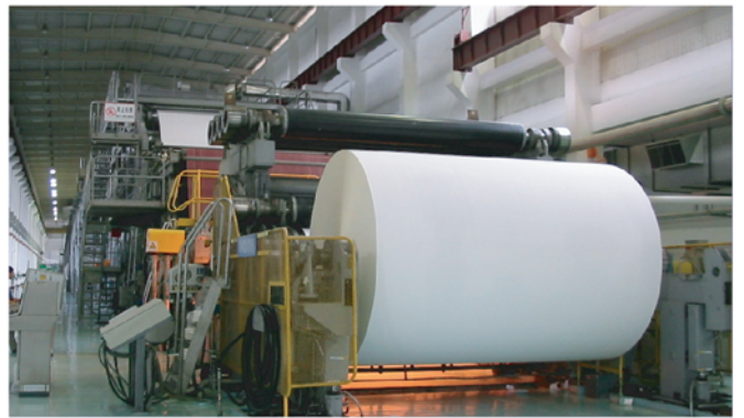
▶ 广西大型造纸企业特大容量电机高压变频软启动
