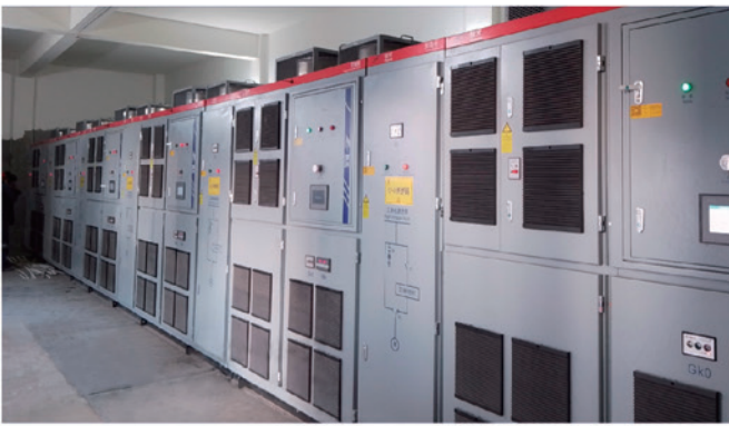
▶ 宁夏科通新材料改造项目
